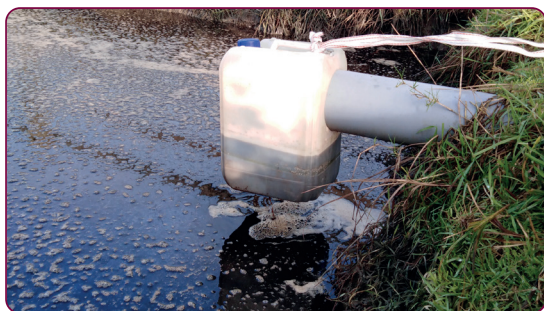
Système de collecte des lixiviats de fumière en amont de la 1 ère lagune (après stockage en fosse) © L. Briot / IFCE
