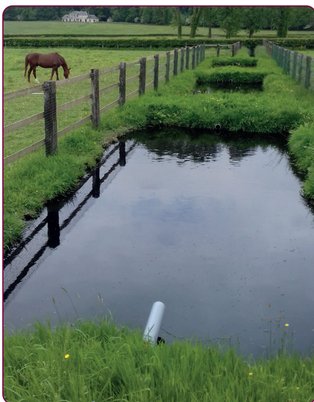
Système de lagunes à 3 bassins (jumenterie du Pin) © L. Briot / IFCE
