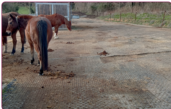
Aire d'exercice perméable munie de dalles de stabilisation (écurie active n°2) © P. Doligez / IFCE
