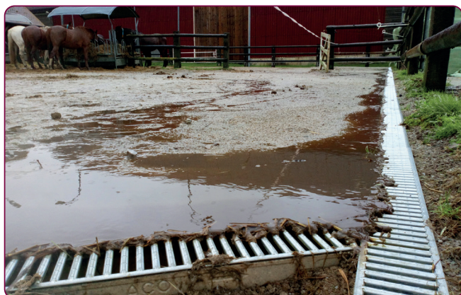
Eaux de ruissellement de l'aire d'exercice, collectées à travers une caniveau (jumenterie du Pin) © L. Briot / IFCE
