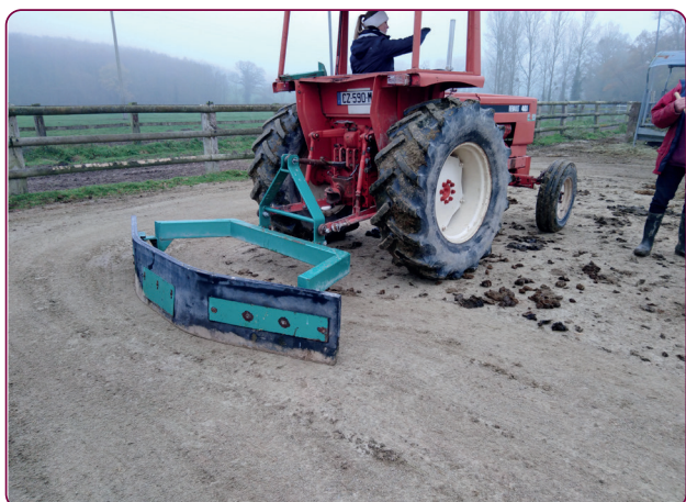
Raclage mécanique de l'aire stabilisée en graves (jumenterie du Pin) © P. Doligez / IFCE
