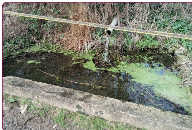
Point de collecte des eaux de ruissellement en aval de l'aire stabilisée (écurie n°2) © P. Doligez / IFCE
