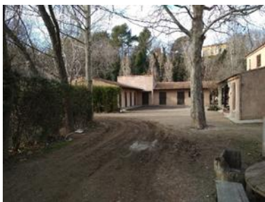
Accès au centre équestre
